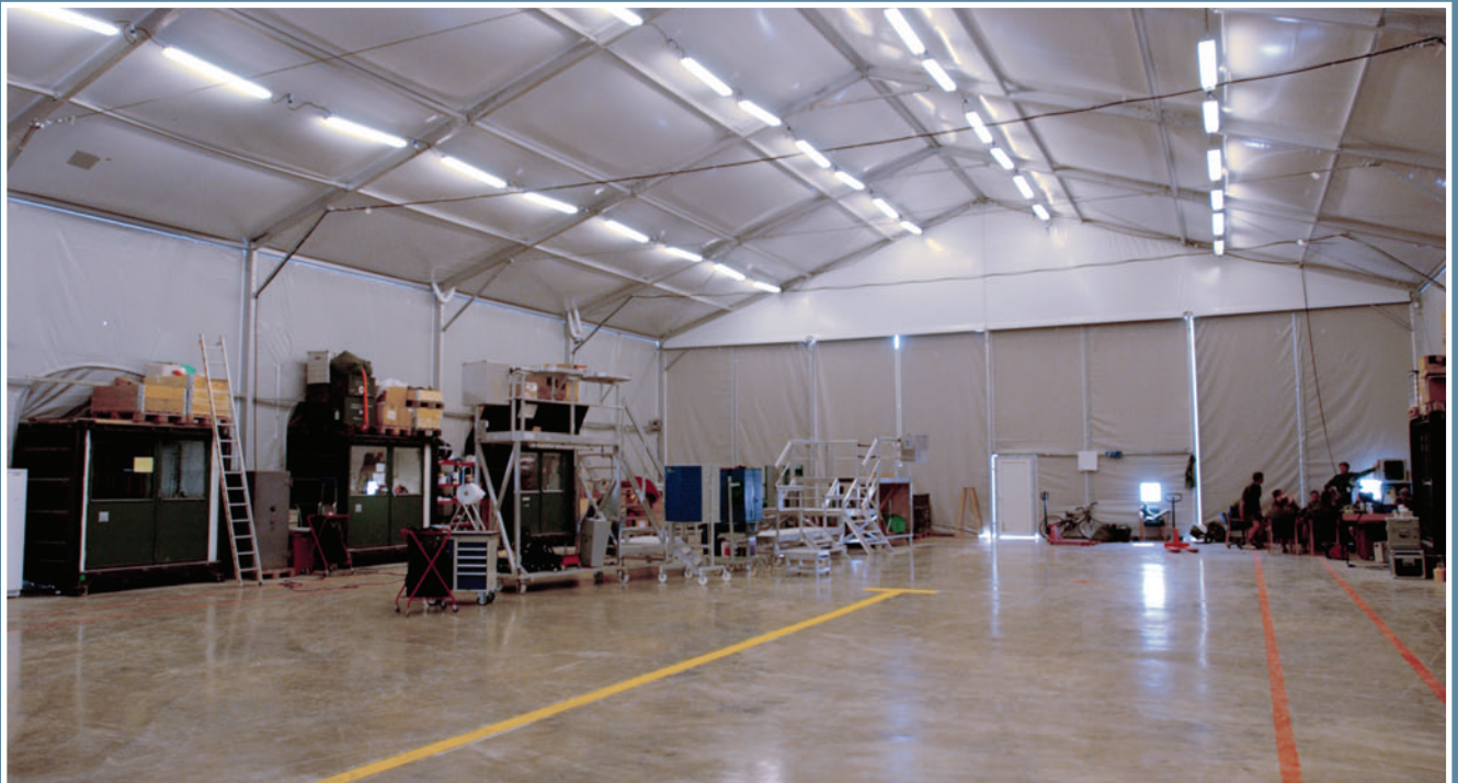
Hangaren ferdig: Merk containerne som åpner innover.
