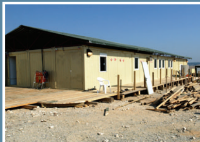
Velferdsriggen står klar, men mangler plattning på utsiden.
