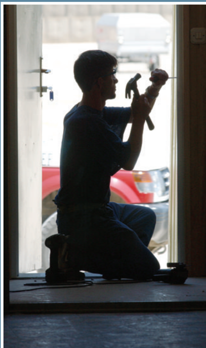
Lokal håndverker i arbeid. Foto: Magnus Iversen, FMS
