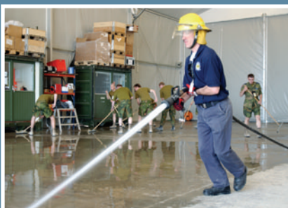
Lokalt ansatt brannmann spylter gulvet før lakking.
