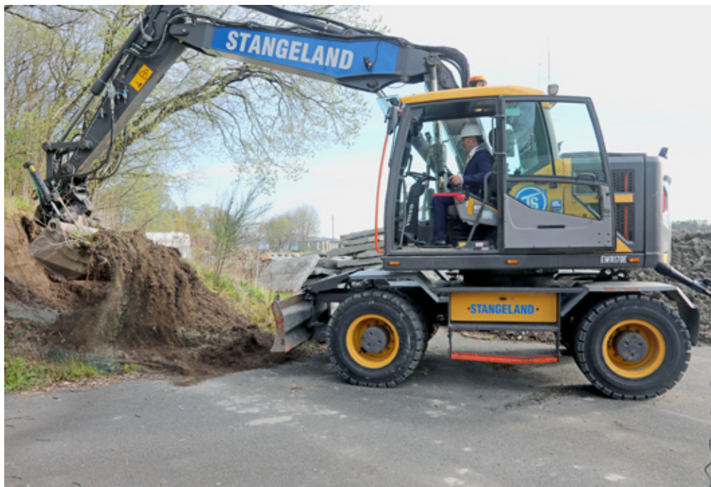
▲ Arbeidet er i gang og det første spadesticket ble utført av ordfører Tom Henning Slethei (Frp) ved spaken i en gravemaskin. Foto: Jan-Petter Helgesen
